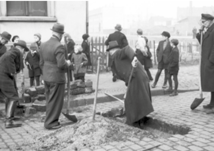
Bau von Straßensperren in der Baumstraße, März 1945
