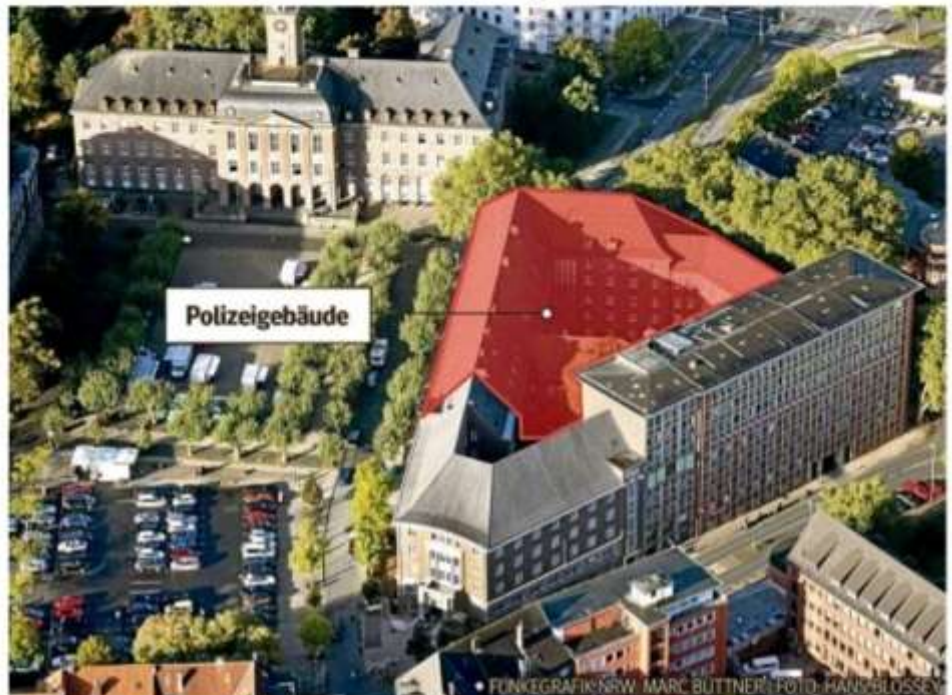
Zum Verkauf steht das Polizeigebäude in Herne-Mitte, dahinter zu sehen: das Rathaus
